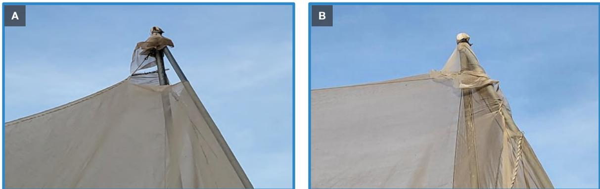
Figura 33. Reparación de roturas con parches de malla. (A) antes del colocar el parche (B) después colocar el parche (Guanacaste, 2022).
