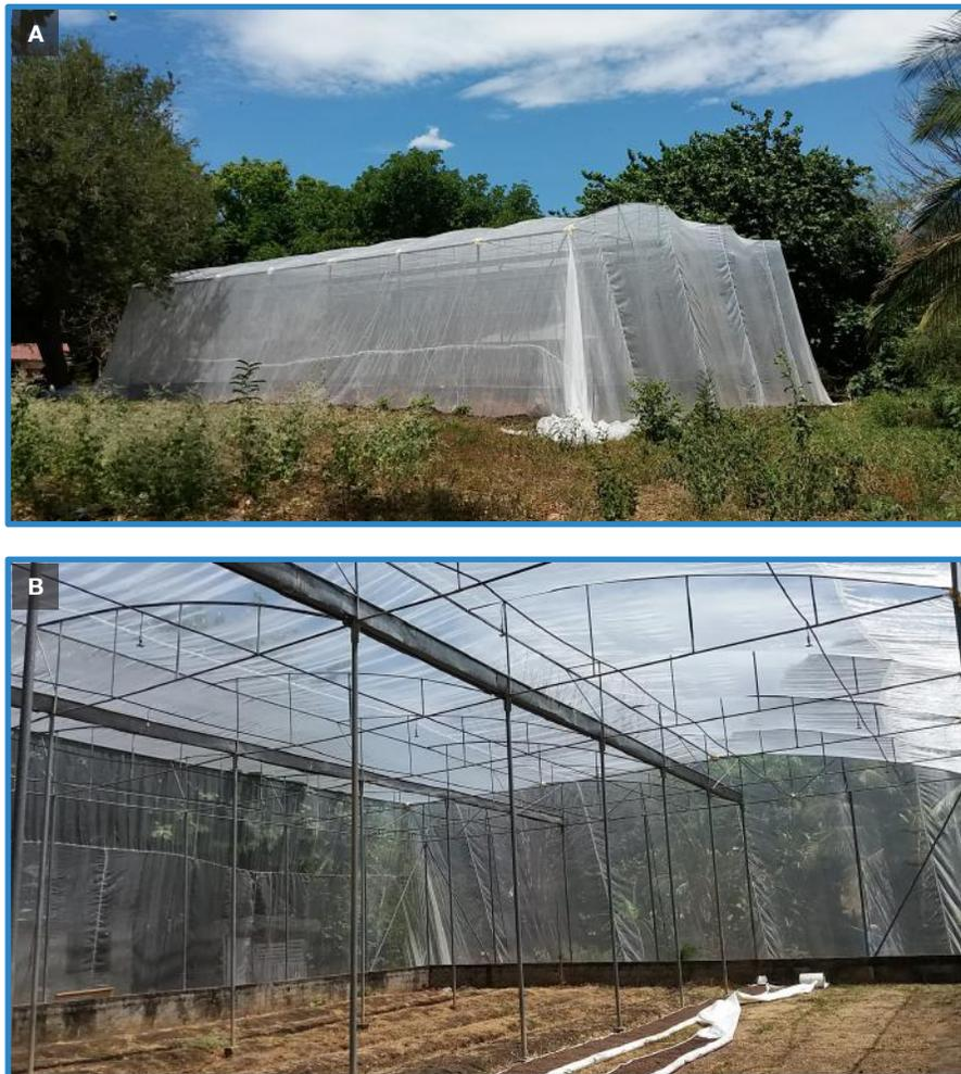
Figura 12. Casa de malla con techo curvo. (A) exterior (B) interior (Guanacaste, 2019).
