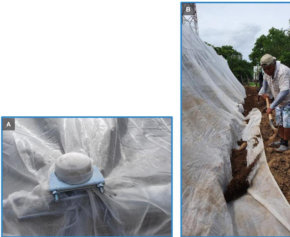
Figura 27. Sujeción de la malla. (A) techo (B) paredes (Puntarenas, 2020).
