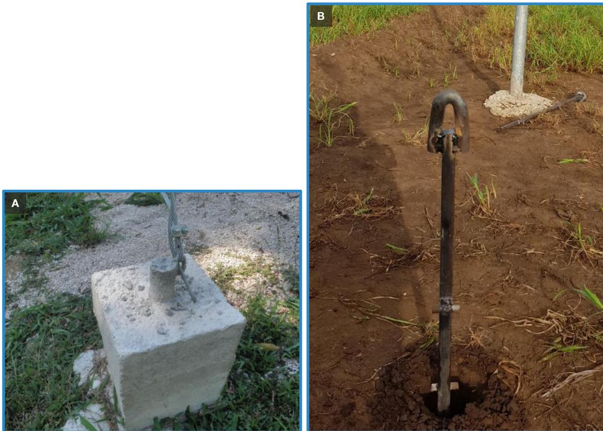
Figura 21. Colocación de anclajes. (A) con columna (B) pilote de varilla lisa (Guanacaste, 2020).
