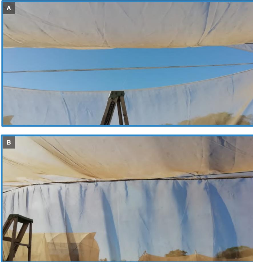
Figura 34. Reparación de roturas con hilo sintético. (A) antes del remiendo (B) después del remiendo (Guanacaste, 2022).
