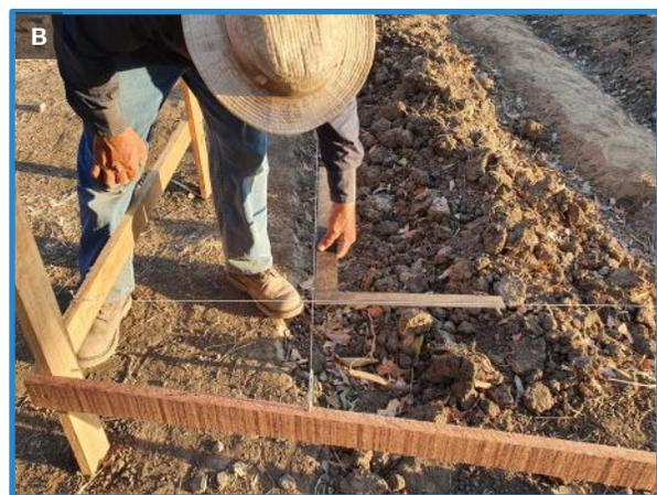
Figura 17. Levantamiento de niveletas. (A) nivel con agua (B) triángulo pitagórico (Puntarenas, 2020).
