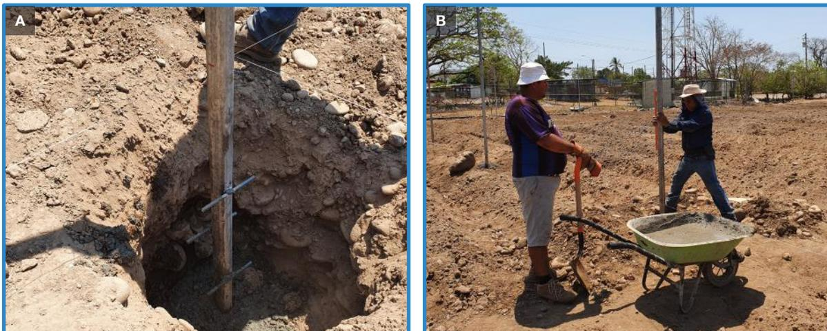
Figura 19. Colocación de columnas. (A) estructura de la base (B) aplomo del tubo con nivel de mano (Puntarenas, 2020).
