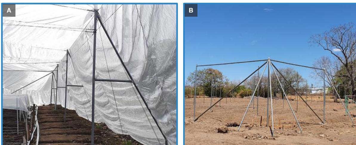
Figura 20. Colocación de arriostres. (A) laterales (B) esquinas (Puntarenas, 2020).
