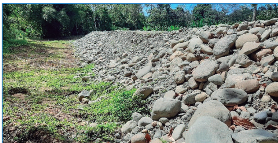
Figura 113. Construcción de muro de protección de áreas de investigación de la EELM.
