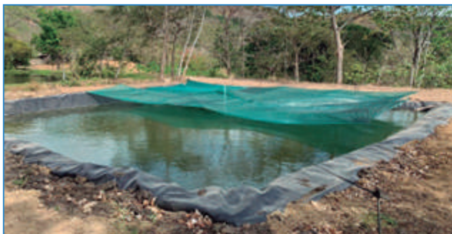
Figura 68. Reservorio de agua. Atenas. 2021
