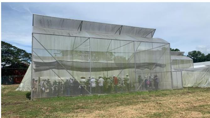
Figura 1. Módulo de invernadero 7m de altura (98 m<sup>2</sup>).
