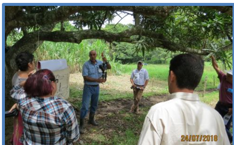
Figura 3. El Ing. Juan Solano muestra a los participantes los componentes del ariete, de bajo costo, que está siendo instalado en la finca del sr. Solórzano.
