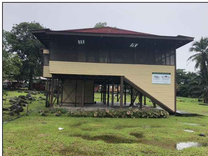
Figura 1. Instalaciones de producción del biocontrolador en EELD.
