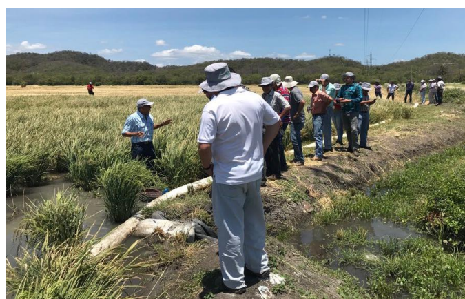
Figura 3. Demostración del funcionamiento del poliducto.
