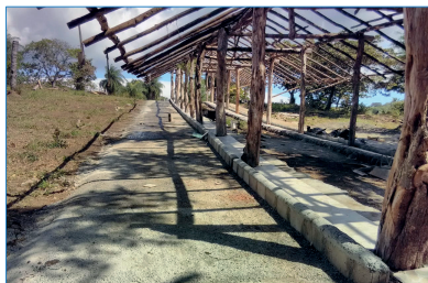
Figuras 1 y 2. Construcción de corral de estabulación. Fuente: Monge, 2019.
