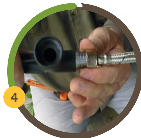
Figura 4: Acople de manguera de abasto y estaca plástica.
