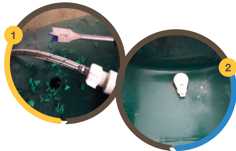
Figuras 1 y 2: Perforado de huecos y colocación de boya sumergible.
