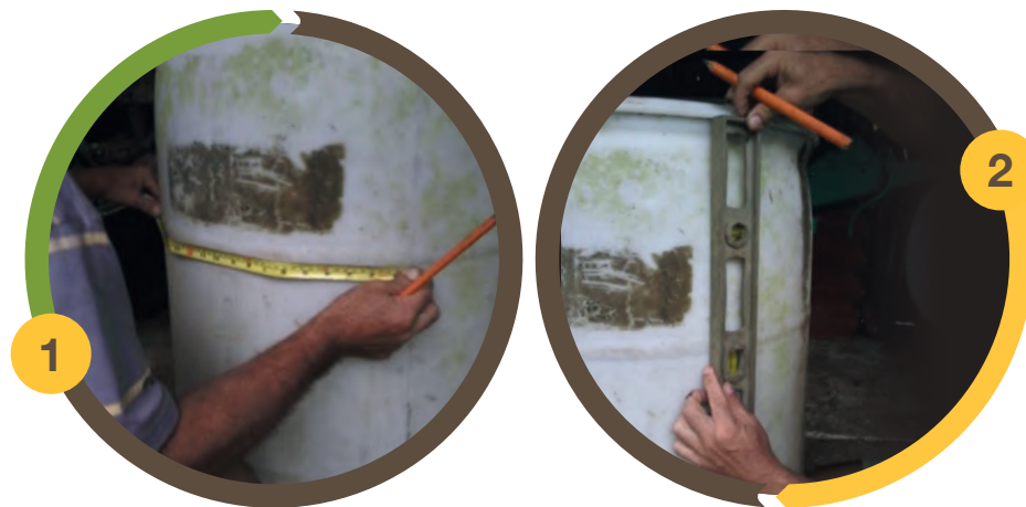
Figuras 1 y 2: Marcado de estañón para hacer puerta móvil. Las líneas verticales deben de ser aplomadas con el nivel.
