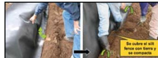
Figura 6. Colocación del geotextil dentro de la fosa de instalación, (Prado, 2007).
