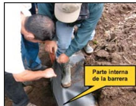
Figura 9. Nivelación del terreno bajo el geotextil y estirarlo para colocar sobre las estacas, (Prado, 2007).
