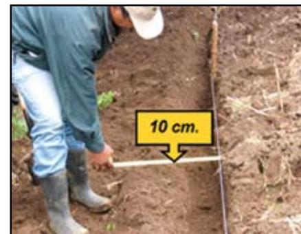
Figura 5. Dimensiones de la fosa de instalación del geotextil, (Prado, 2007).
