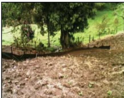
**Figura E.** Erosión atrapada por el silt fence en parcela Oeste. (Prado, 2007).
