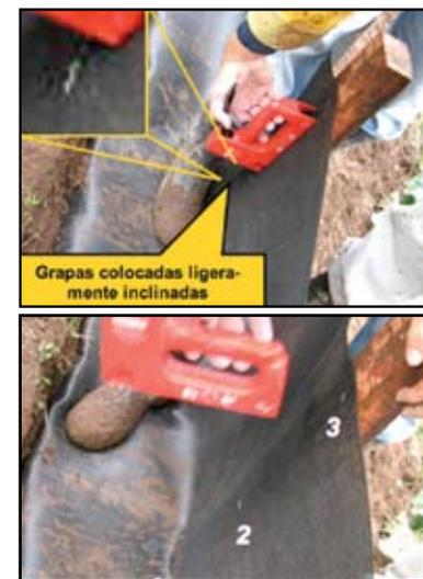
Figura 10. Colocación de las grapas para la fijación del geotextil a las estacas, (Prado, 2007).
