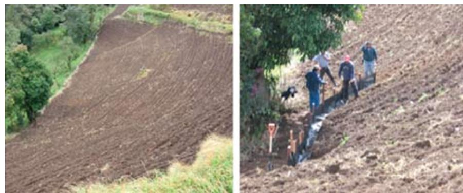
Figura D. Proceso de instalación de la barrera de geotextil, (Prado, 2007).
