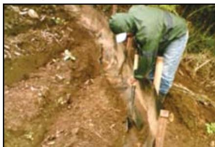
Figura 13. Limpieza de la barrera de geotextil luego de la recolección del sedimento, (Prado, 2007).
