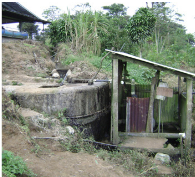
Figura 14. Sistema de bombeo propulsor de estiércol de vaca. Finca de don José Sobrado en Los Ángeles de San Ramón, Provincia de Alajuela, Costa Rica
