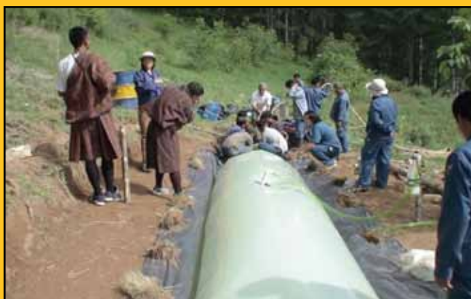
Foto 15. Una vez inflada la bolsa se procede a llenarla de agua hasta establecer el sello de agua, que ocurre cuando se alcanza un nivel que sobrepase unos 20 cm sobre el borde superior de las alcantarillas
