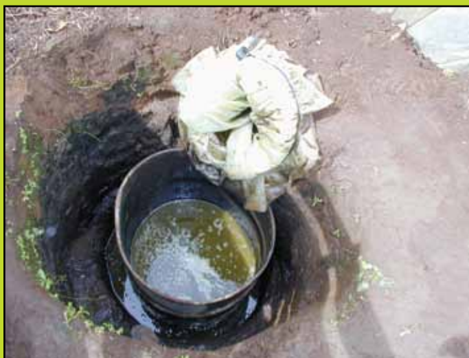
Foto 18. Instalación del recibidor del efluente (Tomado de Fernando Martínez)
