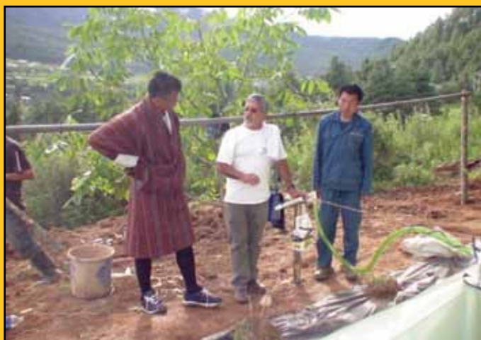
Foto 16. Instalación final de la bolsa tubular, con sello de agua, válvula de seguridad y armazón del techo que protegerá el biodigestor de la lluvia, el sol y daños por animales o personas.
