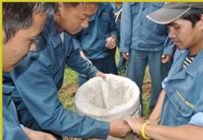
Foto 4. Forrado de las alcantarillas antes de colocarlas, para proteger la bolsa plástica de daños por efecto del filo de los bordes.
